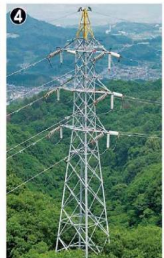
④ 外部電源(送電線)
